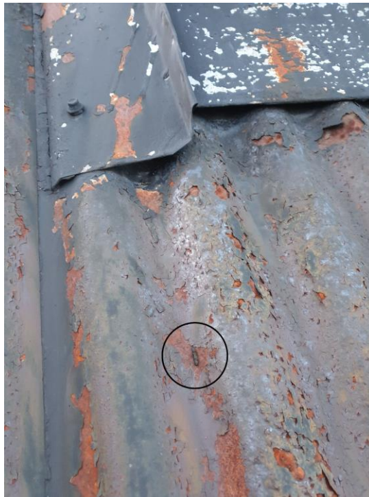
Kuva 10. Pohjanlepakon kulkuaukot sijaitsevat melko usein savupiipun pellin ja katon saumakohdassa. Tässä tapauksessa päiväpiilon paljastaa yksi katolle jäänyt papana (ympyröity) (Ville Vasko).
